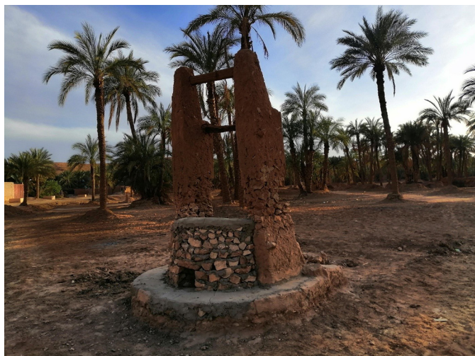
Fig. 3. Un puits de recharge réhabilité dans la vallée du M'zab.
